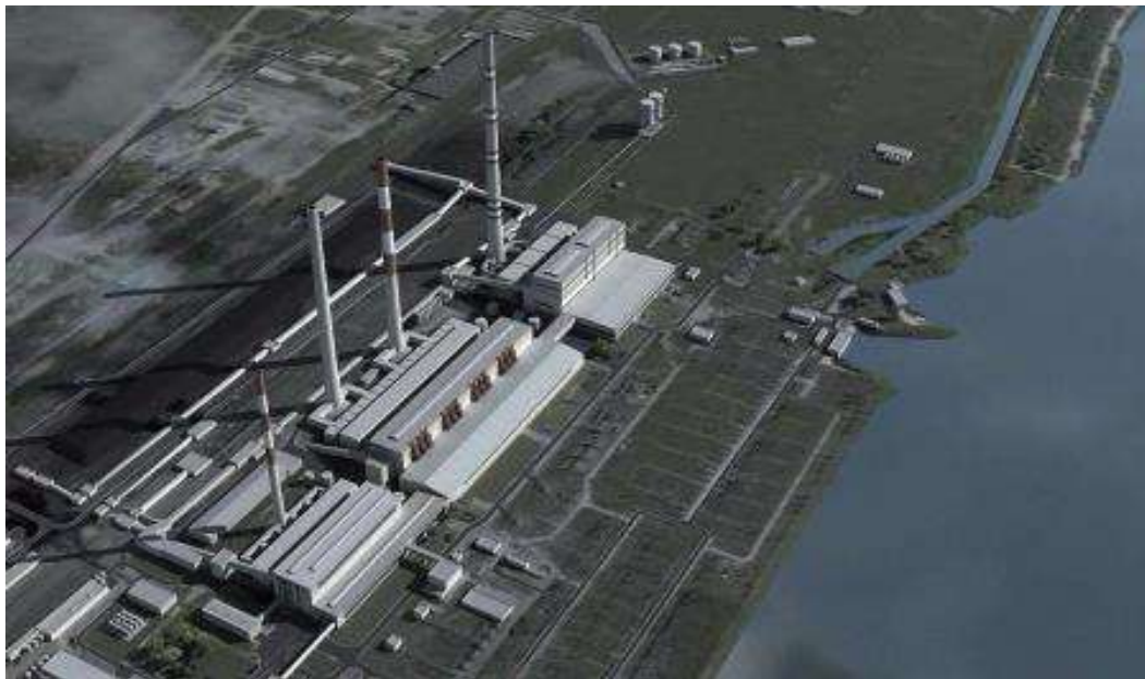
Блок № 10 Троицкой ГРЭС
