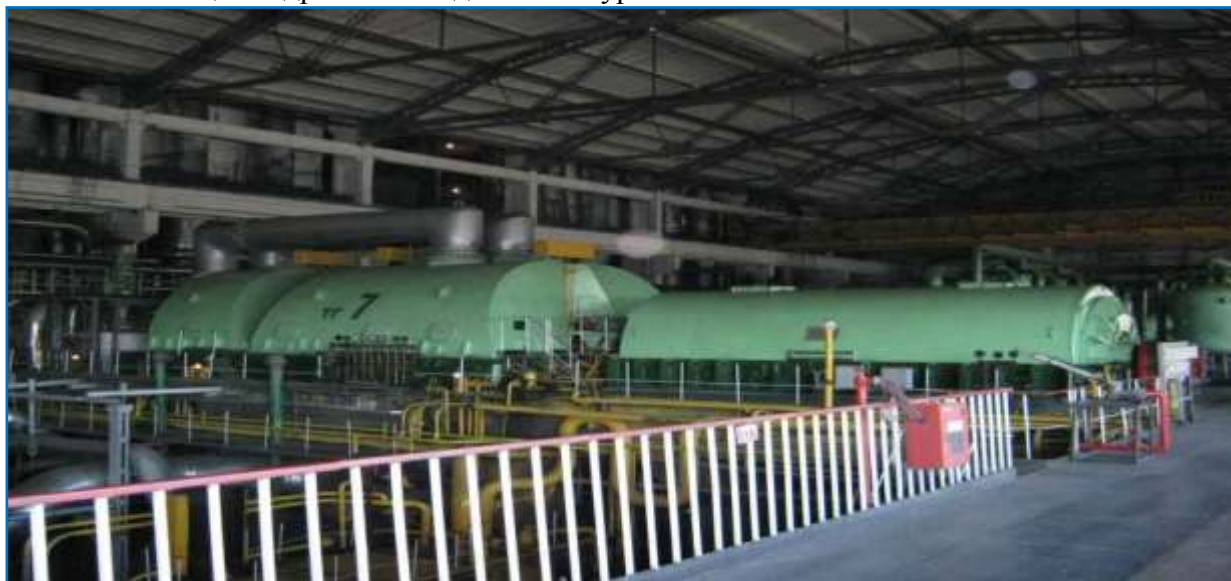
Рис. 13. Реконструированный энергоблок №7 Новочеркасской ГРЭС
