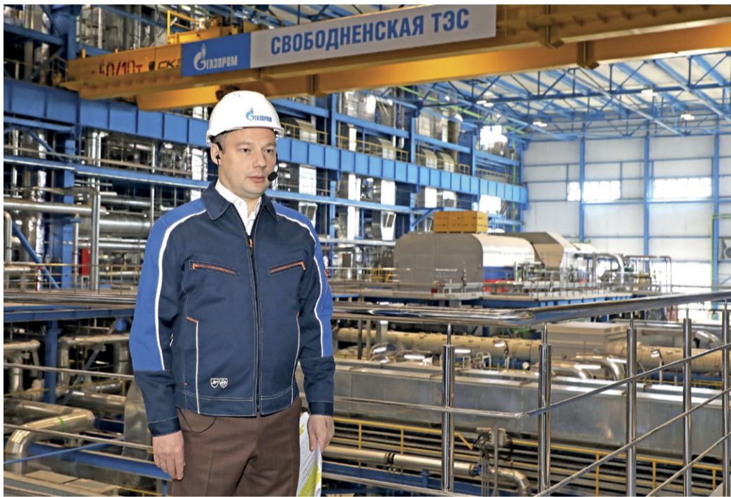
Турбины в работе, станция несет номинальную нагрузку в 160 МВт и готова к подаче пара на Амурский ГПЗ. Из машинного зала ТЭС докладывает Денис Федоров, генеральный директор ООО «Газпром энергохолдинг»
