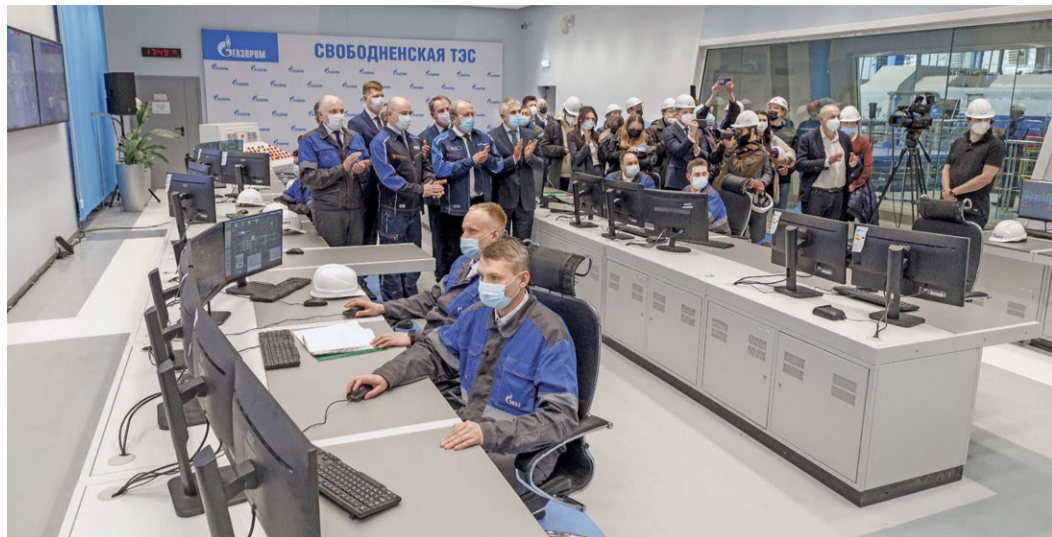
Свободненская ТЭС введена в эксплуатацию! На главном щите управления станции звучат аплодисменты от участников и гостей мероприятия
