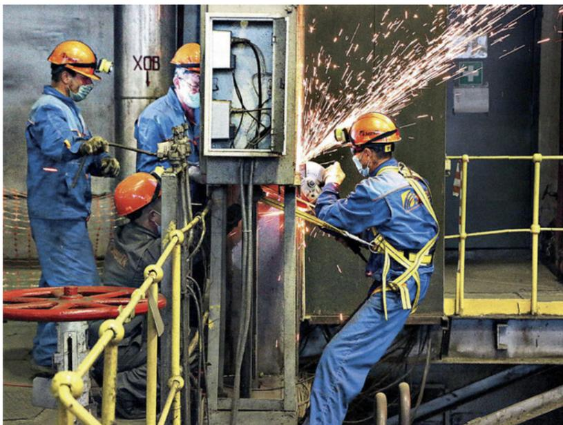
Демонтаж вспомогательного оборудования турбины ТГ-2Т
