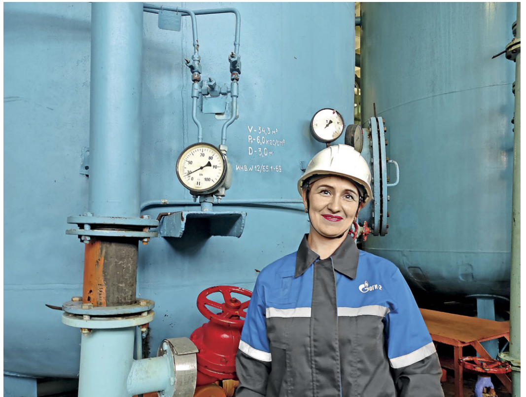
На фото Наталья Вернигора, инженер-технолог химического цеха Троицкой ГРЭС
