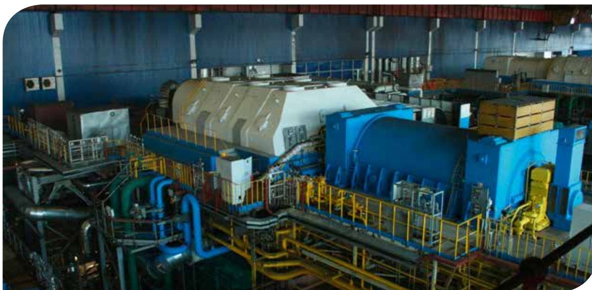
Реконструированный энергоблок №2 Рязанской ГРЭС
