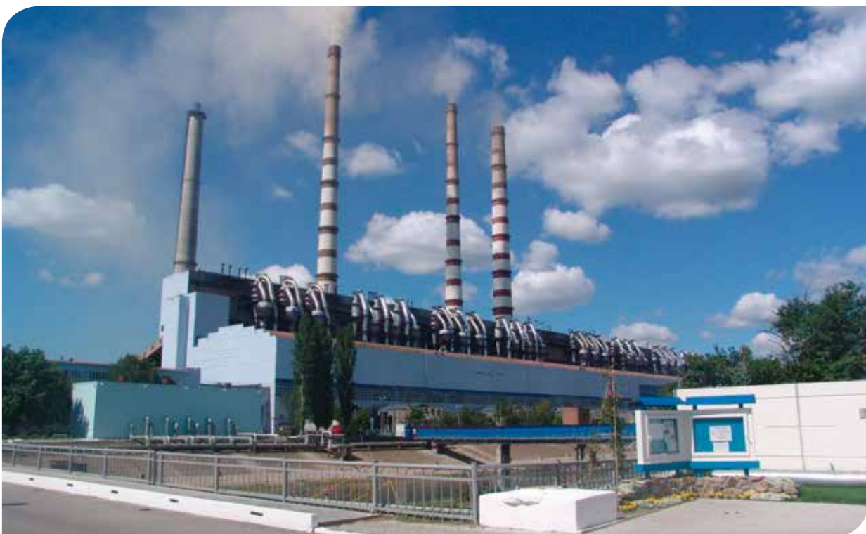
Блок №9 Новочеркасской ГРЭС
