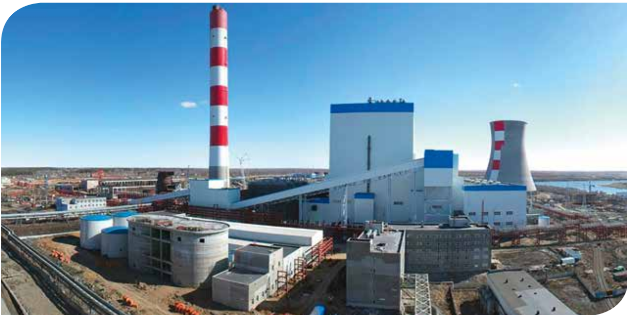
Блок №10 Троицкой ГРЭС
