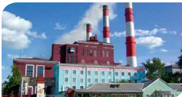
Реконструкция энергоблока ПГУ-420 на Серовской ГРЭС 420 МВт
