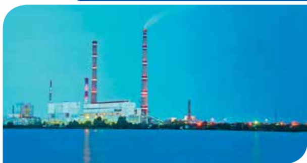
Реконструкция энергоблока ПСУ-330 на Рязанской ГРЭС 330/60 МВт
