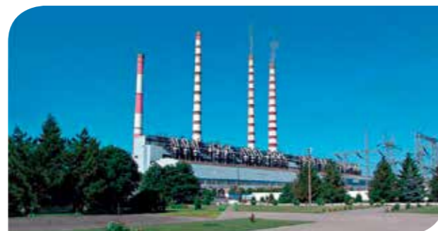
Реконструкция энергоблока ПСУ-330 на Новочеркасской ГРЭС 330 МВт
