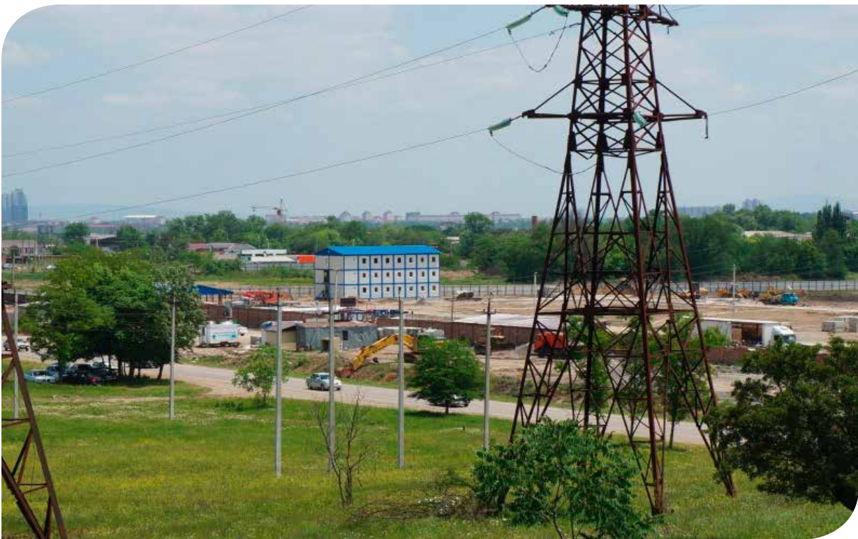
Строительная площадка Грозненской ТЭС, июль 2015 г.
