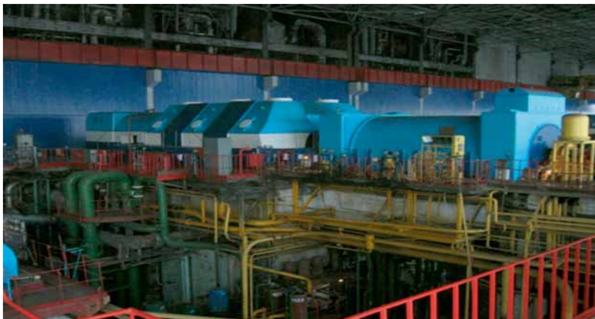
Рис. 12. Реконструируемый энергоблок № 2 Рязанской ГРЭС
