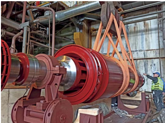
Заводка ротора в статор генератора
