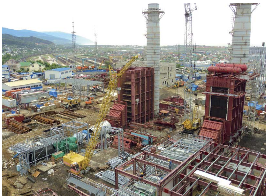
Строительство Адлерской ТЭС началось в 2009 году
