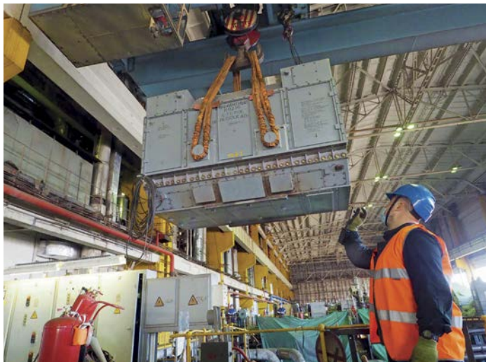
Монтаж генератора на Киришской ГРЭС
